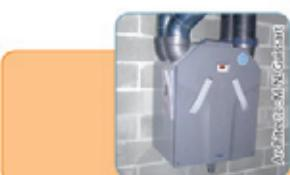
Le système D avec récupération de chaleur est vivement conseillé. C'est le système le plus performant : grâce à un échangeur, il permet de récupérer jusqu'à 90% de la chaleur contenue dans l'air rejeté.
